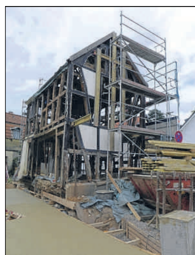
Das entkernte Fachwerkhaus an der Basteistraße. FOTO: BONGARTZ
